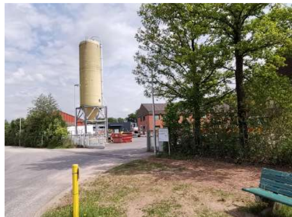
Quelle: eigenes Foto September 2020
